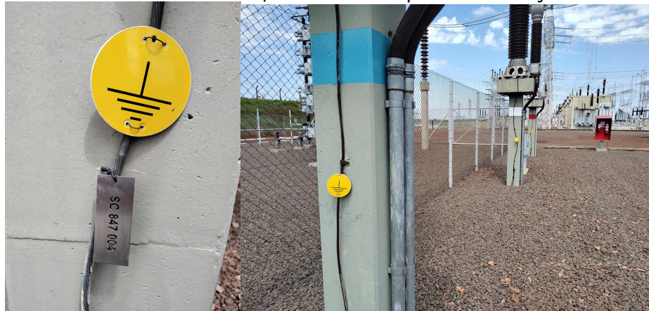
Figura 2: Exemplo da sinalização do Aterramento Elétrico Permanente
